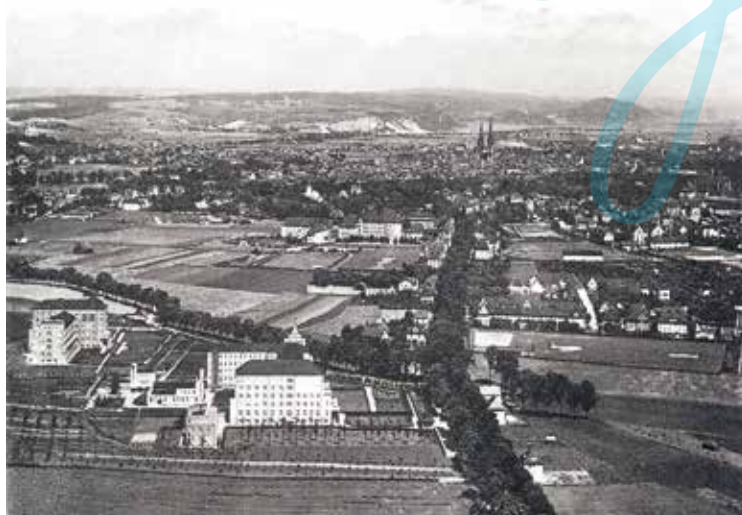
Luftaufnahme des Krankenhauses aus dem Jahr 1935.
